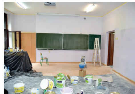
Remont sali lekcyjnej w Szkole Podstawowej nr 4
