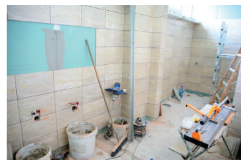
Remont sanitariatów w Szkole Podstawowej nr 2
