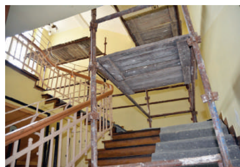
Remont korytarza w I Liceum Ogólnokształcącym
