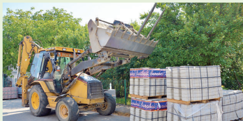
W miesiącu lipcu rozpoczęły się prace związane z przebudową chodników na ul. Górnej w Kościanie. Koszt prowadzonej inwestycji to ponad 260 tysięcy złotych.
