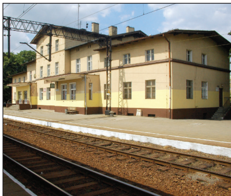
Szpecące elewację budynku napisy i rysunki, zgodnie z informacją zawartą w piśmie zostały już zamalowane.
