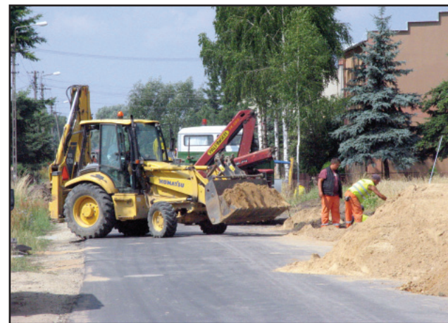
Trwa przebudowa drogi w miejscowości Pelikan.
