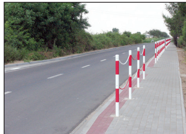
Bezpieczny chodnik dla pieszych w Osieku.
