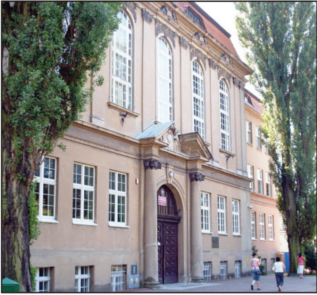
W I Liceum Ogólnokształcącym w Kościanie w ramach termomodernizacji wymieniono 61 okien.
