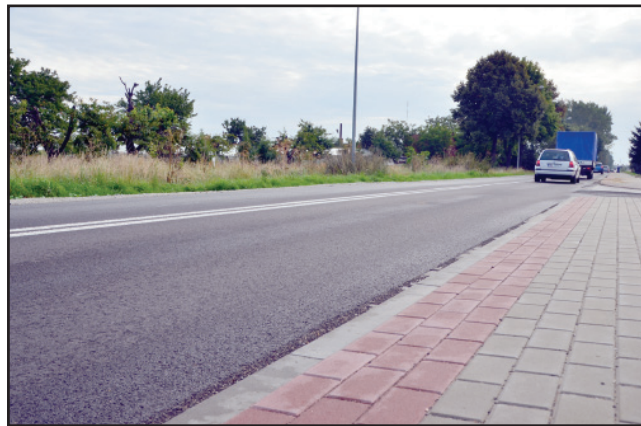
W ramach prac, które kosztowały ponad 255 tys. złotych położono m.in. nową nawierzchnię. Powstał także bezpieczny chodnik.
