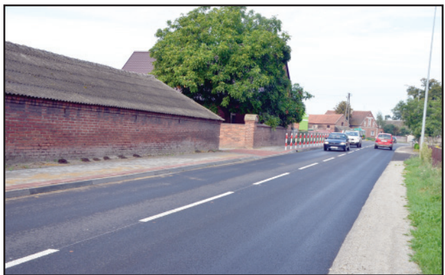
Zakończyły się prace modernizacyjne drogi powiatowej w Poladowie.
