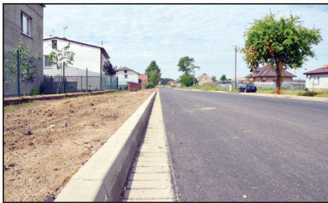
Powiat Kościański wyremontował drogę w Wieszkowie.
