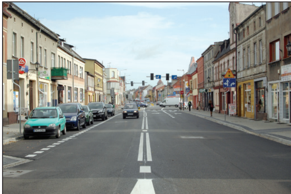
Wyremontowana ulica Piłsudskiego. W przyszłym roku kolej na aleje T. Kościuszki.
