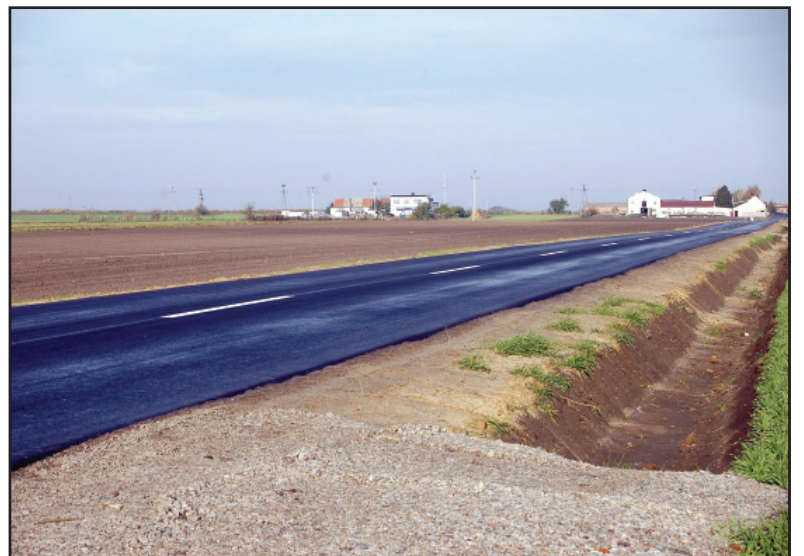
Kończą się prace na drodze powiatowej z Czarkowa do Gryżyny. Koszt inwestycji to ponad 4 miliony złotych.
