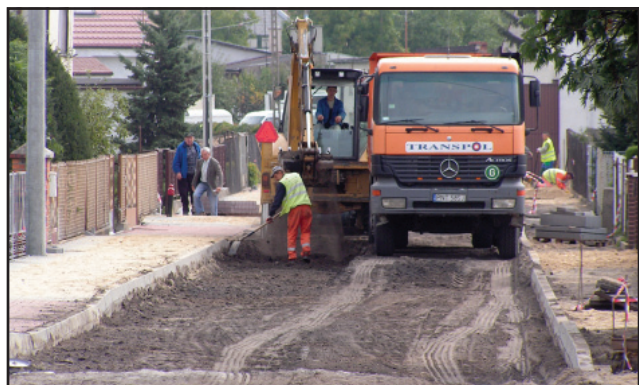
Trwa przebudowa ul. Prostej, najdłuższej ulicy jaką w tym roku buduje miasto.
