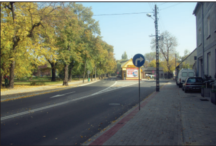
Zmodernizowano ulice i chodniki wokół placu Wolności.
