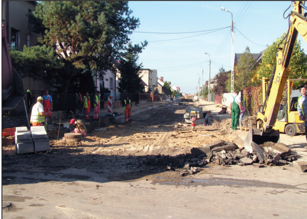
Na ul. Prostej trwają intensywne prace
