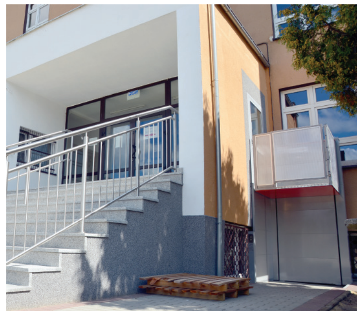
Wykonane nowe schody i podnośnik dla osób niepełnosprawnych w Zespole Szkół Ponadgimnazjalnych w Kościanie kosztował ponad 100 tys. złotych.
