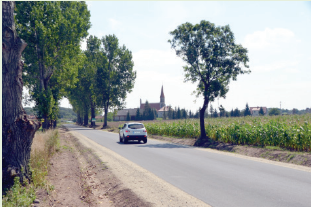
Koszt przebudowy drogi Gniezów- Wonieść wyniósł 714 tys. złotych. Inwestycję kwotą prawie 300 tys. wsparła Gmina Śmigiel.
