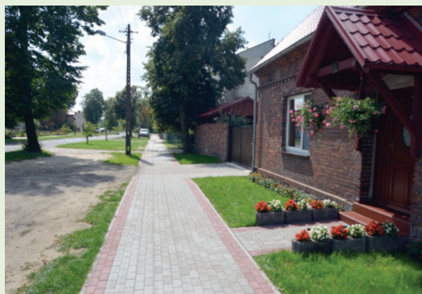
W Starym Bojanowie wykonano z kostki brukowej ciąg pieszo - rowerowy. Inwestycja kosztowała 72 tys. złotych. Środki pochodziły z budżetu powiatu.
