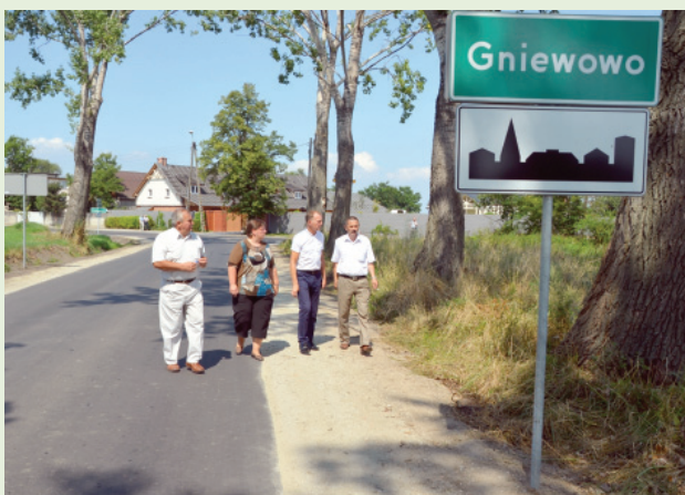
Na odebranej drodze położono nową nawierzchnię bitumiczną.
