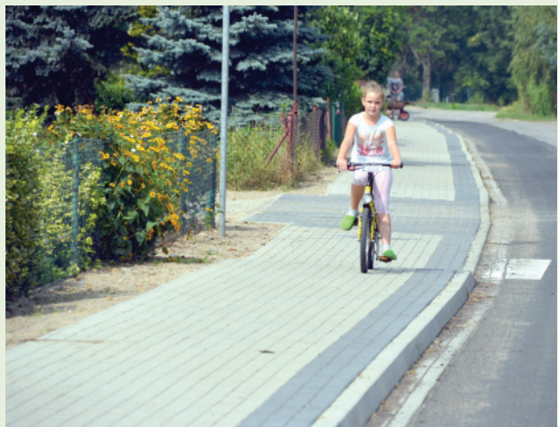
Ciąg pieszo - rowerowy w Darnowie to kontynuacja ubiegłorocznej inwestycji, budowy ścieżki rowerowej z Darnowa do Racotu.
