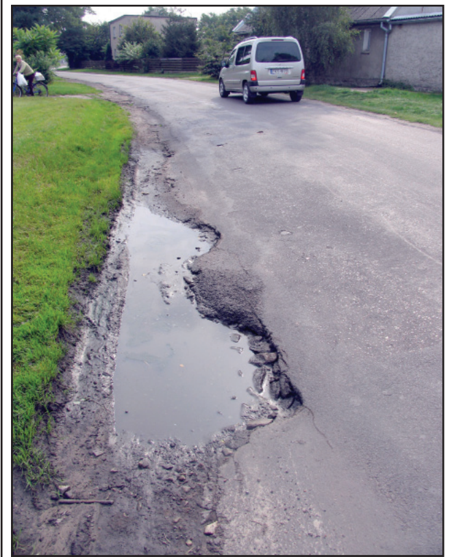
Droga w Pelikanie będzie wyremontowana już w tym roku.
