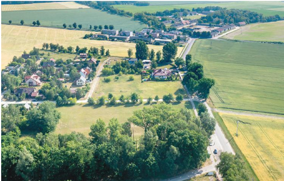
W Nowym Dębcu powstanie nowy parking (fot. Piotr Nędzewicz)
