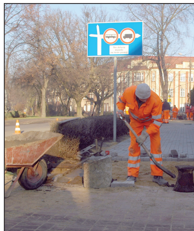
W Kościanie wyremontowano chodnik wzdłuż ulicy Bączkowskiego.
