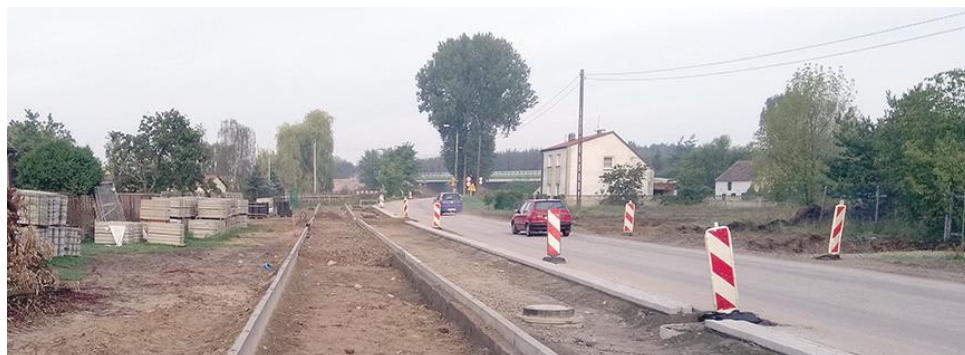
Budowa ulicy Polnej w Kiełczewie
